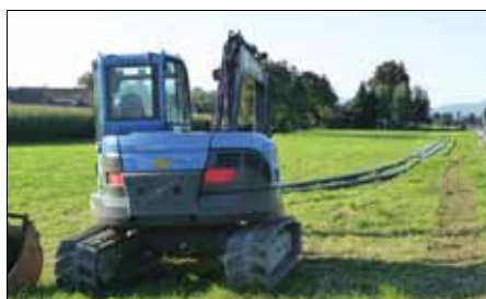
Die Rohre sind zur Verlegung bereit.
