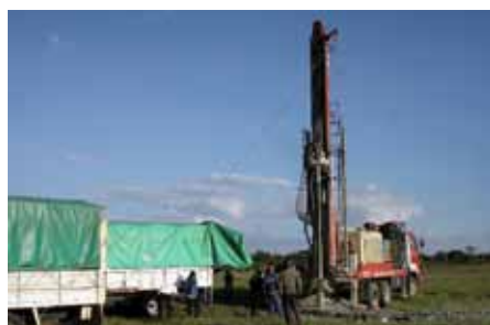
Hightech-Maschinen bohren nach Grundwasser.
